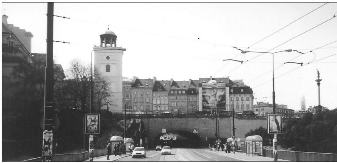
Tunel Trasy W-Z w Warszawie wymaga kapitalnego remontu
