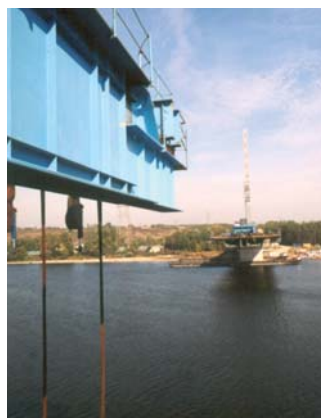
Konstrukcja belki do montażu wspornikowego
