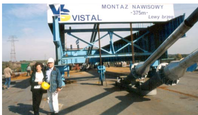
Zakotwienie lin podwieszonoego i koniec pomostowy belki do montażu wspornikowego
