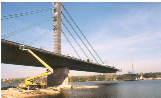
Widok na most z lewego brzegu rzeki
