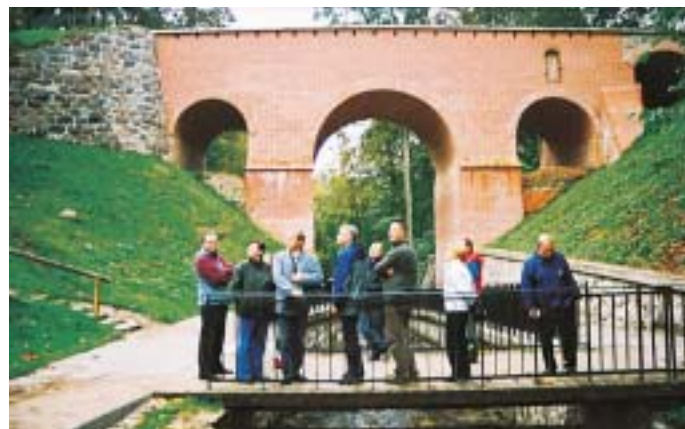
Odbudowany most w Reszlu
