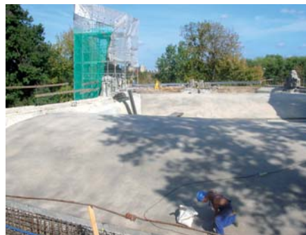
Sklepienia po wzmocnieniu
