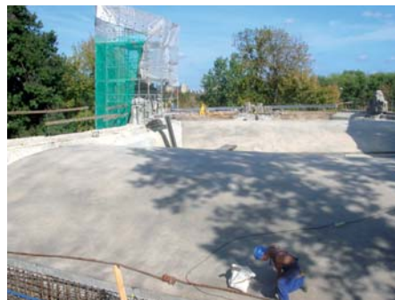
Sklepienia po wzmocnieniu
