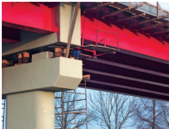
Podpora środkowa – przed opuszczeniem konstrukcji na łożyska
