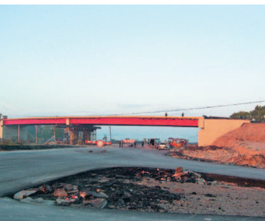
Widok ogólny po zabetonowaniu płyty i poprzecznic
