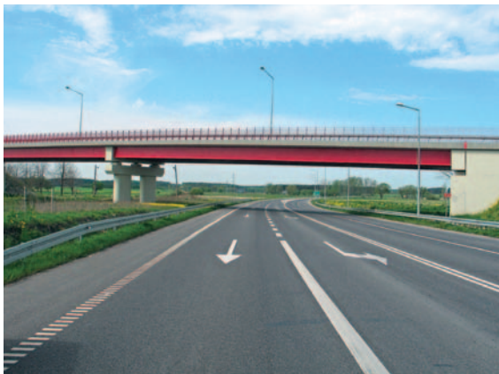
Widok ogólny wiaduktu po zakończeniu budowy
