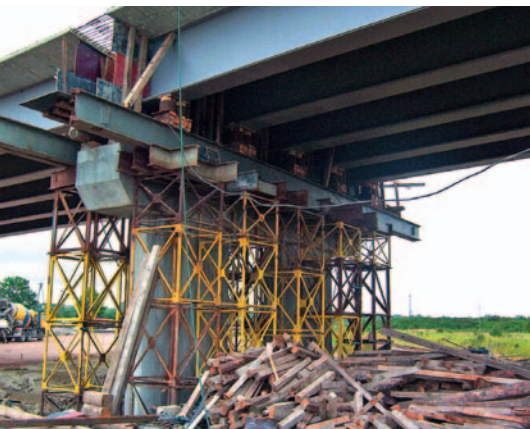
Dźwigary prefabrykowane na podporze pośredniej
