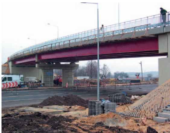
Widok ogólny wiaduktu w czasie budowy
