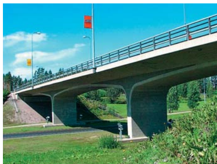
Ramowy most sprężony, Jalasjärvi, Finlandia
