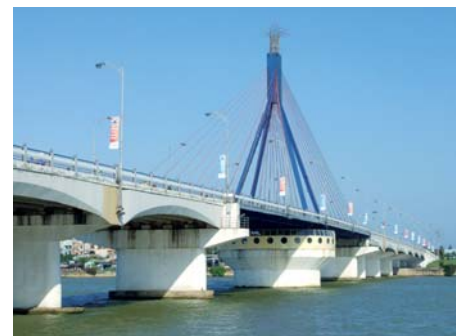
Danang Bridge. Most z obrotowym pylonem
