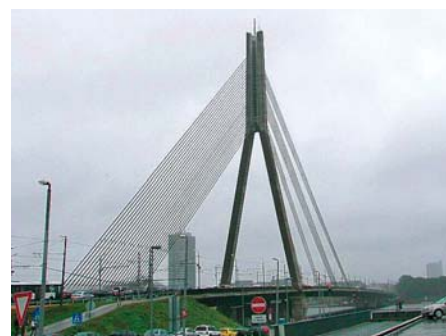
Jednopylonowy most podwieszony, Ryga
