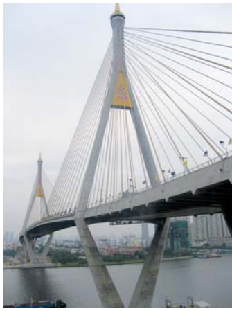
Mega Bridge 1 na obwodnicy Bangkoku
