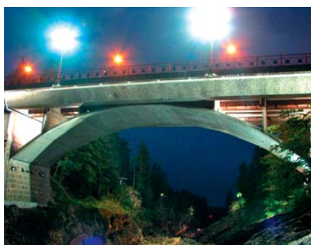
Most żelbetowy ze sklepieniem łukowym, Imatra, Finlandia
