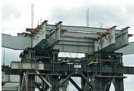
Segment mostu w Puławach
