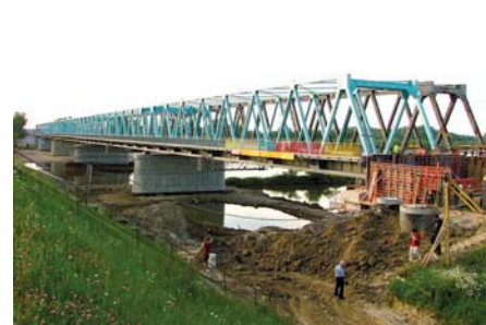
Most drogowy i most kolejowy w Nagnajowie
