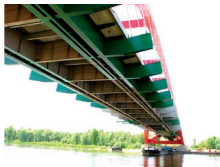
Widok stalowego rusztu mostu w Puławach
