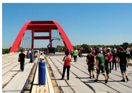
Uczestnicy wyprawy na budowie mostu w Puławach
