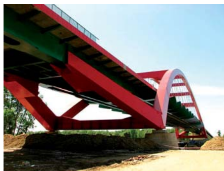
Widok przęsła nurtowego nowego mostu w Puławach
