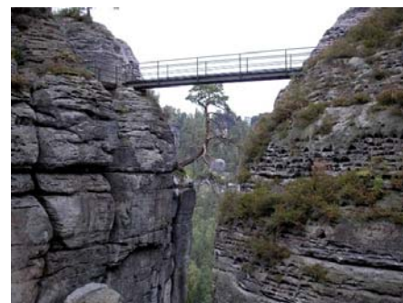
Rys. 6. Uzupełnienie szlaku turystycznego – mostek stalowy
