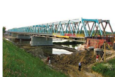
Most drogowy i most kolejowy w Nagnajowie
