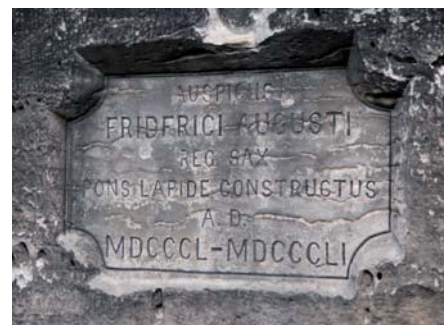
Rys. 7. Tablica upamiętniająca budowę mostu kamiennego
