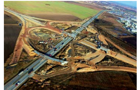
Władysław Kluczewski Budowa węzła Nowa Wieś w ciągu AOW
