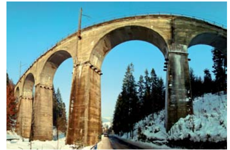
Piotr Rychlewski Most kolejowy przez potok Łabajów w Wiśle (2)
