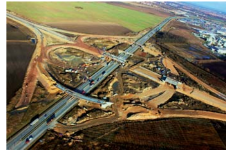
Władysław Kluczewski Budowa węzła Nowa Wieś w ciągu AOW
