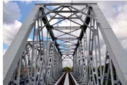
Mariusz Prędota Wiadukt kolejowy na linii Warszawa – Terespol (9)
