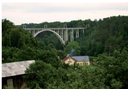
Bechyně – żelbetowy drogowo-kolejowy (1928 r.)
