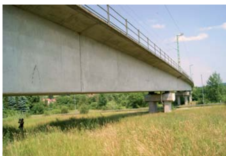
Wiadukt kolejowy w Nagyrákos (2001 r.)
