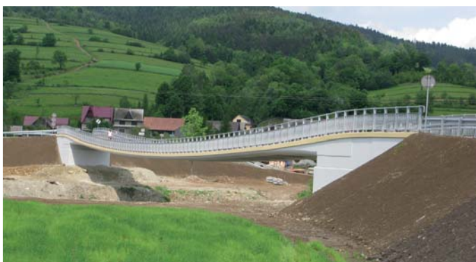
Rys. 1. Kładka pieszo-jezdną w Lubniu
