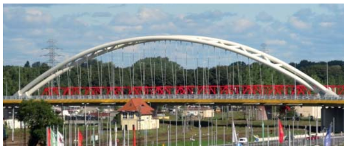
Wiadukt WD-1 w ciągu Trasy J. Słowackiego w Gdańsku
