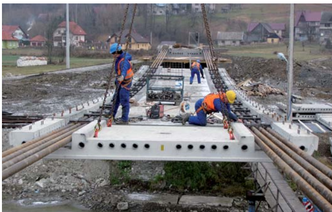
Rys. 5. Montaż wieszaków podtrzymujących element
