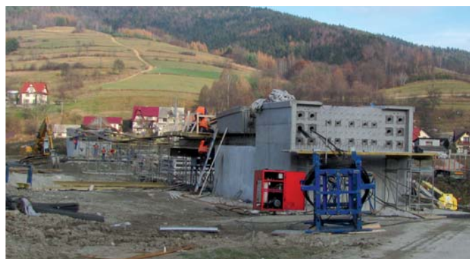
Rys. 2. Korpus przyczółka z łożem ślizgowym
