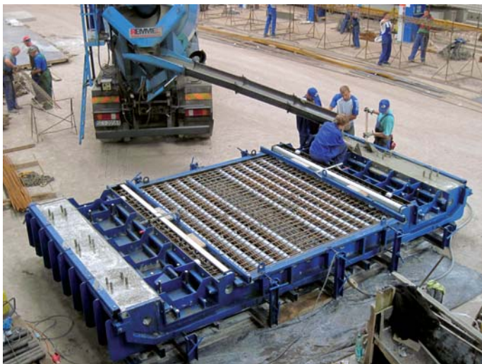
Rys. 4. Betonowanie segmentu w specjalnej formie
