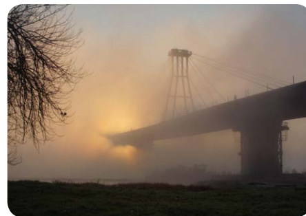
III nagroda – Marek Rzytelewski (Bydgoszcz) „Poranek w Solcu nad Wisłą” – budowa mostu przez Wisłę w m. Kamień
