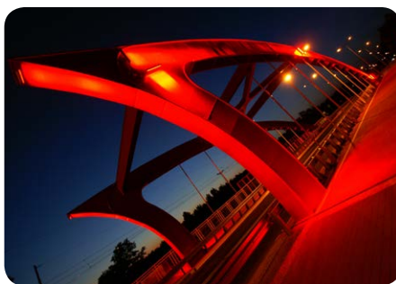
II nagroda – Michał Delmaczyński (Bydgoszcz) Wiadukt na ul. Gdańskiej w Bydgoszczy
