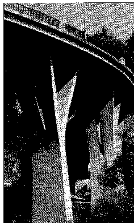
Żelbetowy most płytowy nad rzeką Słunj w (Chorwacja)
