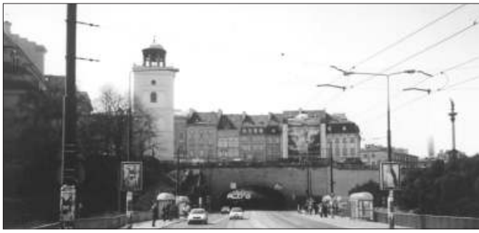
Tunel Trasy W-Z w Warszawie wymaga kapitalnego remontu
