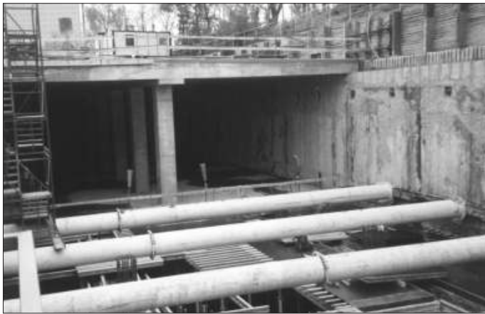
Wykop stacji w ścianach szczelinowych rozpartych rozporami rurowymi
