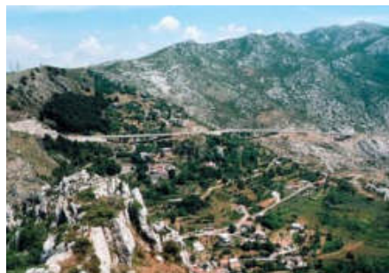
Rys. 15. Wiadukty – widok z murów zamku Klis
