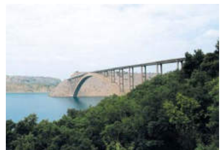
Rys. 13. Fragment mostu na wyspę Krk
