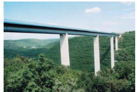
Rys. 10. Trasa Poreč-Rovinj. Wiadukt Limska Draga: długość 552 m (80 + 100 + 160 + 100 + 80 m), szerokość 12 m, wysokość nad terenem 125 m, zbudowany w latach 1989–1991
