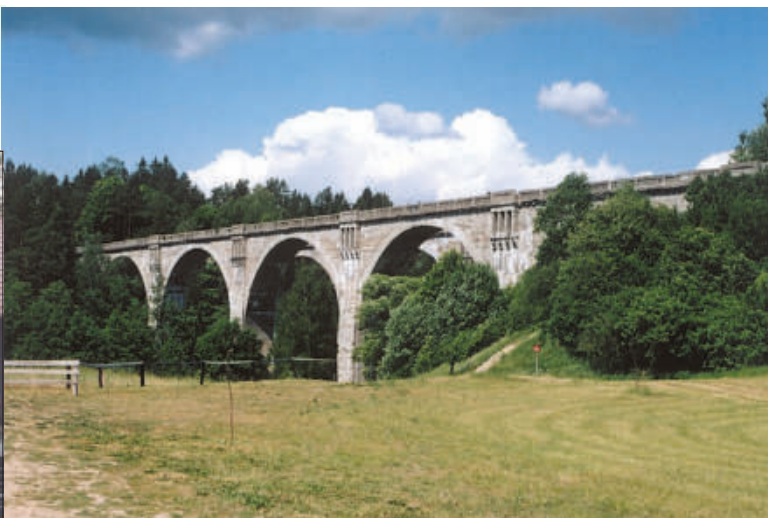
Wiadukty w Stańczykach zbudowane w latach 1912–1926
