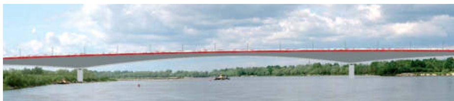
Wariant 1 – most z betonu sprężonego
