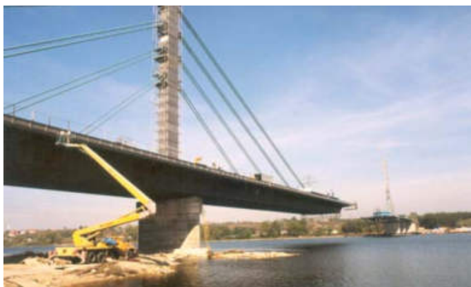
Widok na most z lewego brzegu rzeki
