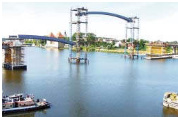
Budowa mostu w Wolinie stan w dniu 30 maja 2003 roku
