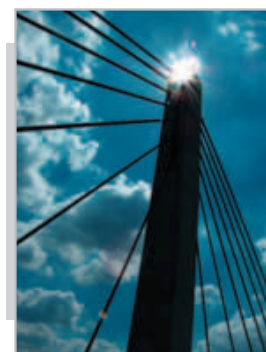
Świeca słońca na pylonie 10 podpory mostu Milenijnego we Wrocławiu Władysław Kluczewski – godło WUKA
