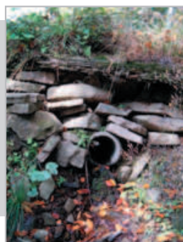
Przepust pod drogą na Klimczok w Szczyrku Jadwiga Wrzezińska – godło KLIMCZOK
