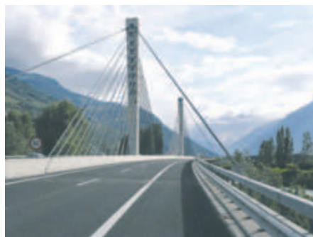
Most podwieszony Chandoline na Rodanie, w pobliżu Sion (dzieło Christiana Menna , 1991 r.)
