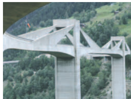
Ganterbrücke – most typu extradosedz z usztywnionymi cięgnami podwieszenia (koncepcja Christiana Menna , konstrukcja Josef Grob , 1980 r.)
