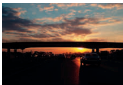
Nowo budowany wiadukt nad Trasą Toruńską w Markach Mariusz Prędota – godło „Filar”
