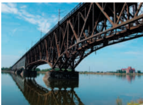
WYRÓŻNIENIE – Czesław Prędoła Most kolejowo-drogowy przez Wisłę w Płocku (3)
