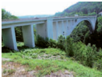
Betonowy most łukowy, La Caille, Francja
