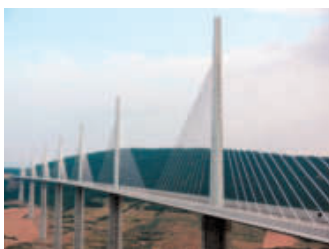
Podniebny wiadukt w Millau, Francja
