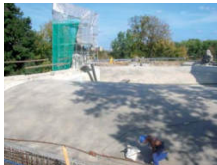
Sklepienia po wzmocnieniu
