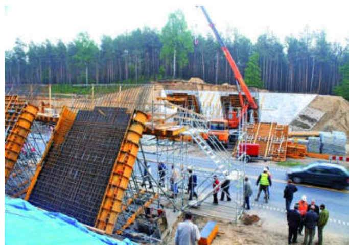
Rys. 2. Budowa kładki dla zwierząt nad drogą Bydgoszcz-Inowrocław
