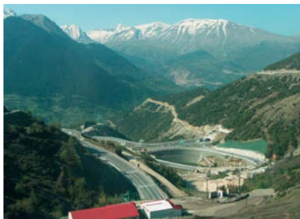
Rys. 15. Region Epiru – kręte autostrady są budowane na stromych zboczach gór. Jak widać na fotografii, w przeciwieństwie do naszego kraju, w Grecji jest możliwa wyraźna ingerencja w środowisko naturalne
