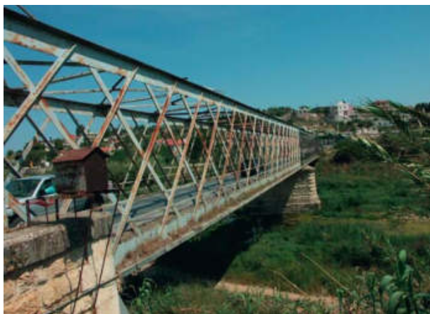
Rys. 11. Most kratownicowy i przydrożna kapliczka, jakich wiele przy greckich drogach
