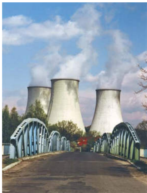
Turoszów – wiadukt nad linią kolejową Piotr Rychlewski – godło „3 kominy”
