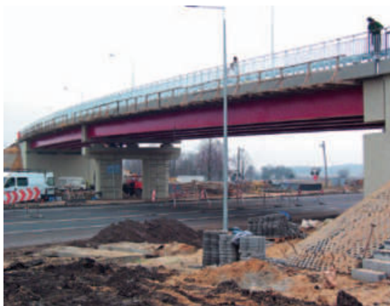
Widok ogólny wiaduktu w czasie budowy
