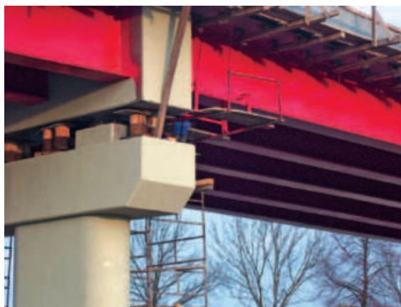
Podpora środkowa – przed opuszczeniem konstrukcji na łożyska
