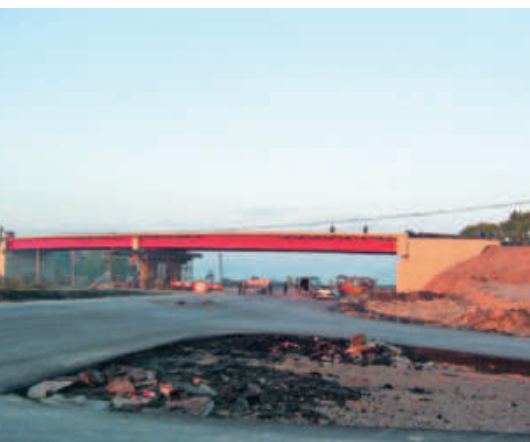
Widok ogólny po zabetonowaniu płyty i poprzecznic
