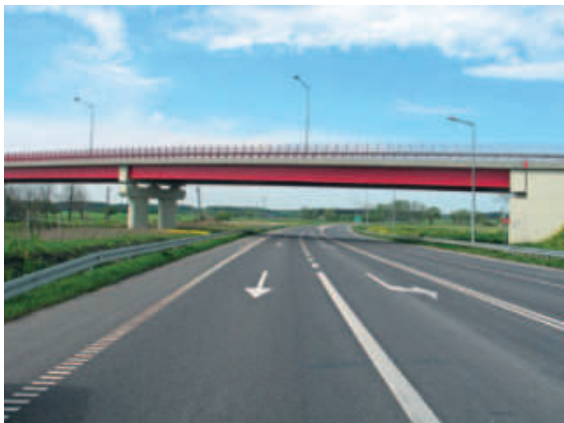
Widok ogólny wiaduktu po zakończeniu budowy
