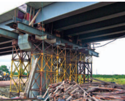
Dźwigary prefabrykowane na podporze pośredniej
