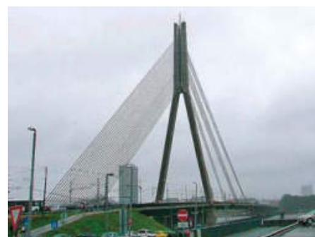
Jednopylonowy most podwieszony, Ryga
