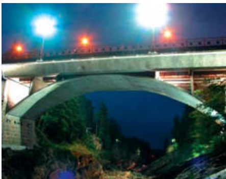
Most żelbetowy ze sklepieniem łukowym, Imatra, Finlandia
