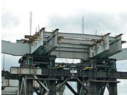
Segment mostu w Puławach
