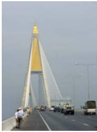
Ring Road Bridge na obwodnicy Bangkoku
