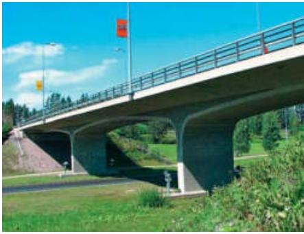
Ramowy most sprężony, Jalasjärvi, Finlandia
