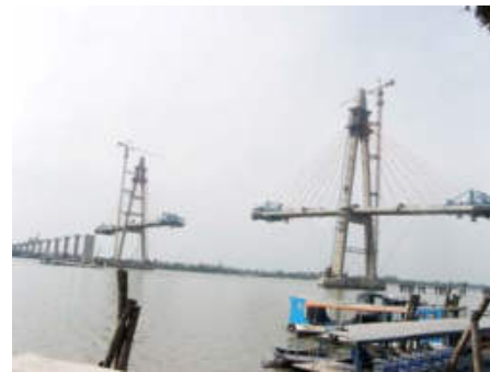
Most podwieszony w budowie w Delcie Mekongu k. Cai Be
