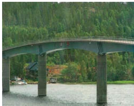
Stalowo-betonowy skrzynkowy most drogowy k. Hornön, Szwecja
