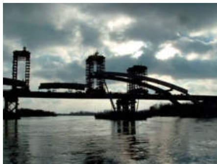
II nagroda – Krzysztof Kania (Sosnowiec) Montaż mostu Puławskiego na Wiśle
