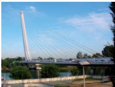
Sewilla – most Alamillo proj. Calatravy przez odnogę Guadalquivir
