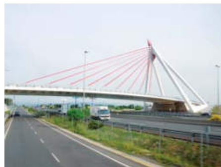
Wiadukt nad A42 koło Madrytu
