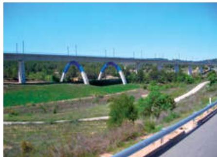
Wiadukt szybkiej kolei AVE koło Barcelony
