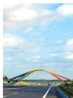
Andrzej Marecki – Tęcza – wiadukt nad A2
