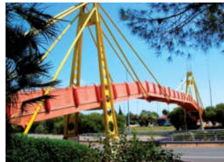
Dziwaczna kładka nad autostradą E-15
