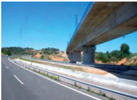
Wiadukt szybkiej kolei AVE koło Lleidy
