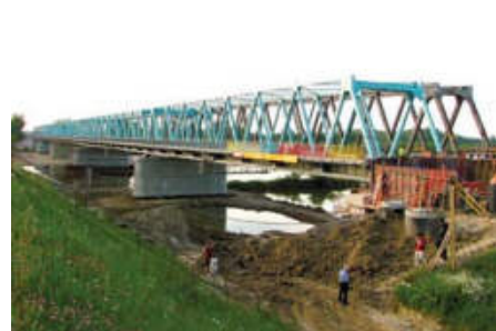
Most drogowy i most kolejowy w Nagnajowie
