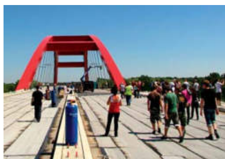
Uczestnicy wyprawy na budowie mostu w Puławach
