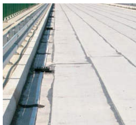
Izolacja i odwodnienie pomostu mostu w Puławach
