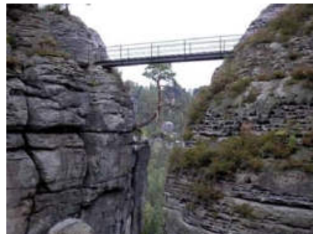
Rys. 6. Uzupełnienie szlaku turystycznego – mostek stalowy
