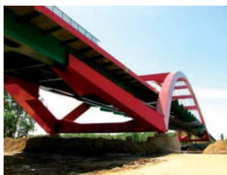
Widok przęsła nurtowego nowego mostu w Puławach
