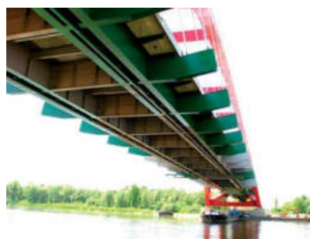
Widok stalowego rusztu mostu w Puławach
