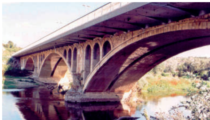
Rys. 19. Żelbetowy most łukowy przez Jantrę w Białej
