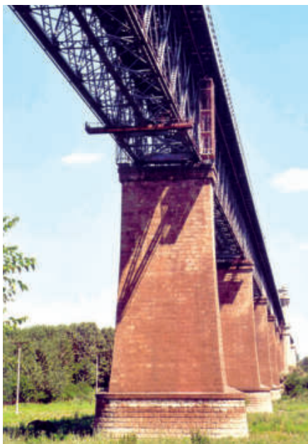
Rys. 25. Podpory estakady dojazdowej do mostu King Karol I przez Dunaj
