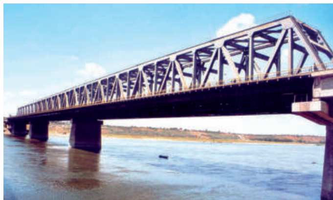
Rys. 23. Nowy kratownicowy most kolejowo-drogowy przez ramię Dunaju Borcea w Fetești
