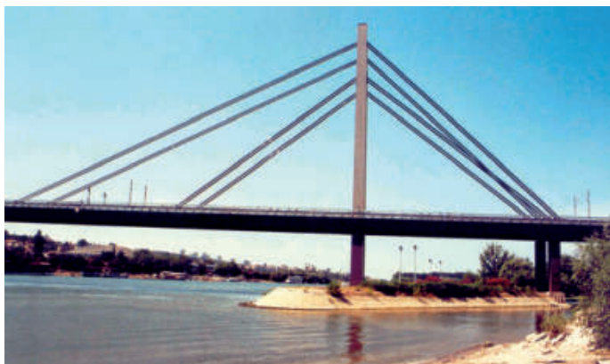
Rys. 13. Nowy Most Kolejowy przez Sawę w Belgradzie
