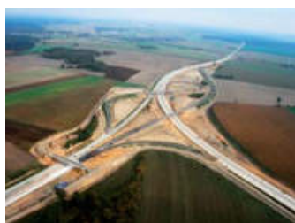
Władysław Kluczewski Wiadukty WD 50C, WD 50A, WD 50B na węźle Krzyżowa
