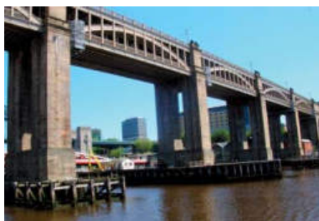
Dwupoziomowy High Level Bridge w Newcastle
