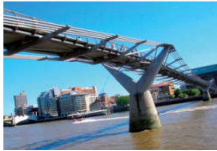
Pechowa kładka Millennium Bridge w Londynie
