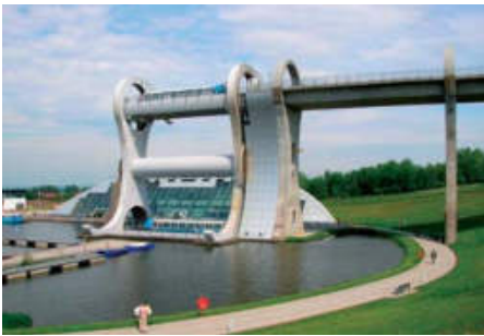
Most kanałowy z obrotnicą (Falkirk Wheel)
