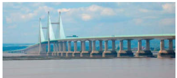
Second Severn Crossing – drugi most przez ujście Severn z 1996 r.
