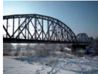
Sławomir Stańczyk Most kolejowy przez Wisłę w Górze Kalwarii
