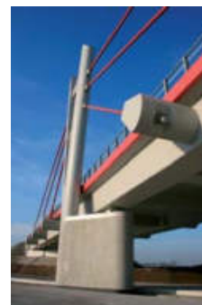
Władysław Kluczewski Wiadukt WD 22 nad autostradą A4
