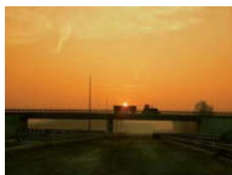
Władysław Kluczewski Próbne obciążenie wiaduktu WD 45 na autostradzie A4
