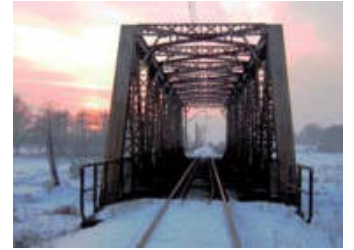
Sławomir Stańczyk Most kolejowy nad rzeką Rządzą
