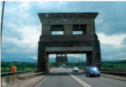
Górny pomost nowego Britannia Bridge przez cieśninę Menai
