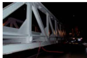
Marek Jusik, Andrzej Urbaniak Wiadukt kolejowy (al.Niepodległości w Poznaniu)
