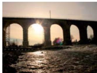
Władysław Kluczewski Wiadukt kolejowy w Bolesławcu
