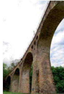
Mariusz Prędota Lewin Kłodzki – wiadukt kolejowy
