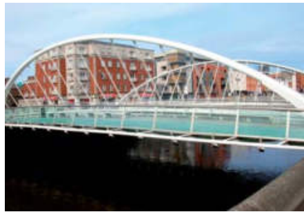
James Joyce Bridge projektu Calatravy w Dublinie
