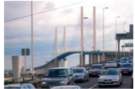
Queen Elizabeth II Bridge w Dartford nad ujściem Tamizy
