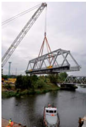
Mariusz Prędoła Mosty kolejowe na linii E65 nad Kanalem Żerańskim w Warszawie (6)
