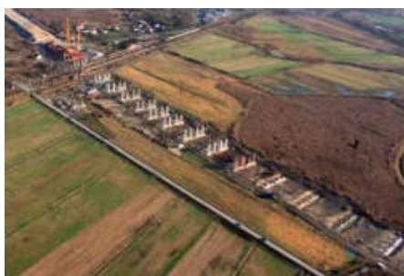
Władysław Kluczewski Budowa wiaduktu WA22 nad polderami na AOW
