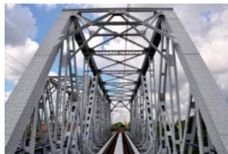
Mariusz Prędoła Wiadukt kolejowy na linii Warszawa – Terespol (9)
