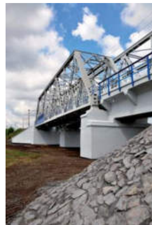
Mariusz Prędoła Wiadukt kolejowy na linii Warszawa – Terespol (8)
