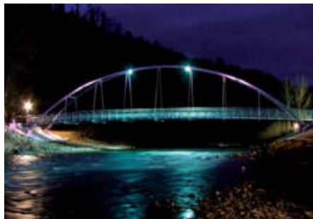
Wyróżnienie – Piotr Rychlewski Kładka dla pieszych przez Sołę w Węgierskiej Górze
