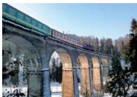
Piotr Rychlewski Most kolejowy przez potok Łabajów w Wiśle
