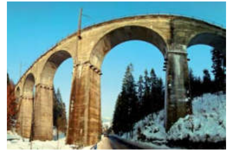
Piotr Rychlewski Most kolejowy przez potok Łabajów w Wiśle (2)
