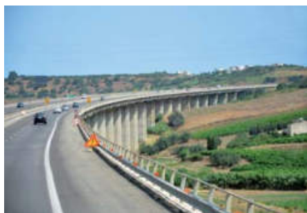
Estakada autostradowa na trasie Marsala – Palermo
