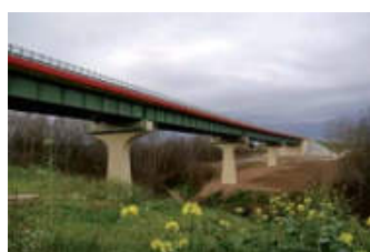
Stanisław Strug (Lublin) – Wiadukt nad wąwozem w ciągu obwodnicy Kraśnika
