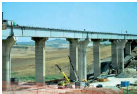
Autostrada na estakadzie w pobliżu Agrigento
