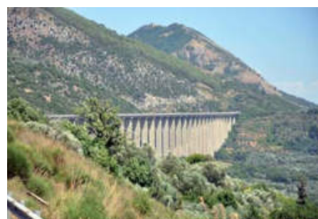
Jeden z wysokich wiaduktów na autostradzie Salerno – Potenza
