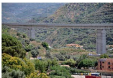
Wiadukt na autostradzie Messina – Palermo
