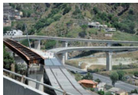
Przebudowa węzła drogowego w okolicy Messiny
