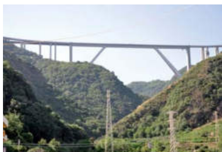
Viadotto Stalassa na autostradzie Salerno – Reggio di Calabria
