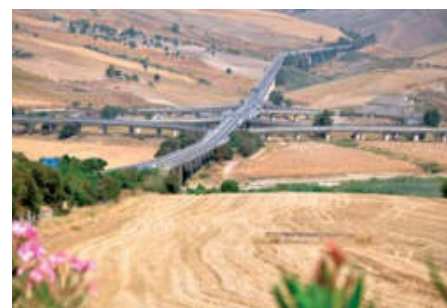
Węzeł autostradowy na odcinku Piazza Armerina – Agrigento
