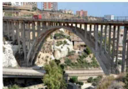
Żelbetowy most łukowy na trasie Agrigento – Selinunt
