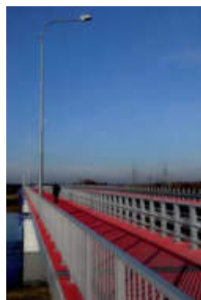
Czesław Prędoła – Małkinia Górna – most w ciągu drogi wojewódzkiej nr 627 nad Bugiem
