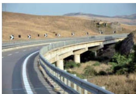
Autostrada Palermo – Catania na wielokilometrowej estakadzie
