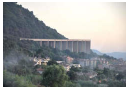
Typowy wiadukt na autostradzie Salerno – Reggio di Calabria
