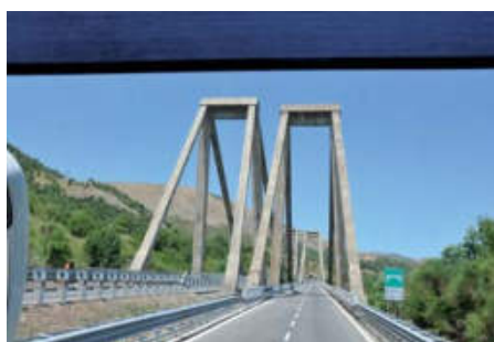
Wiadukt podwieszony Carpineto ze sztywnymi ciężnami na autostradzie Salerno – Reggio di Calabria
