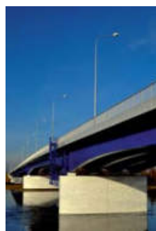
Czesław Prędoła (Warszawa) – Malkinia Górna – most w ciągu drogi wojewódzkiej nr 627 nad Bugiem
