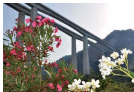
Viadotto Malpertugio na autostradzie Messina – Palermo
