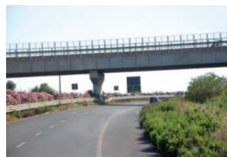
Ciągły wiadukt prefabrykowany na autostradzie Syrakuzy – Gela
