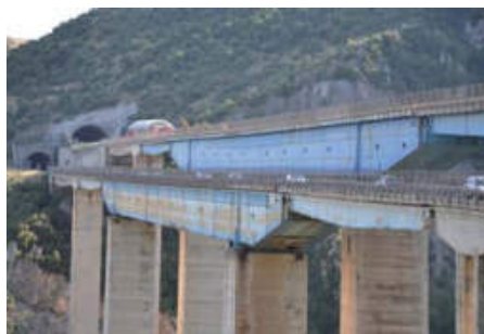
Viadotto Rago na autostradzie Salerno – Reggio di Calabria
