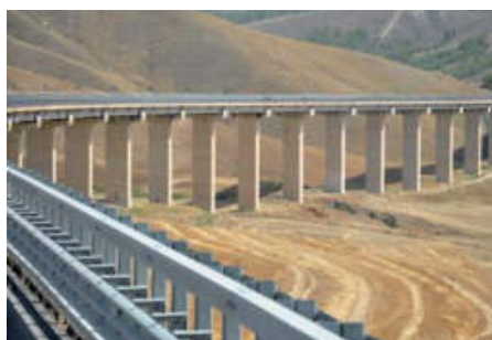
Autostrada na estakadzie na odcinku Piazza Armerina – Agrigento
