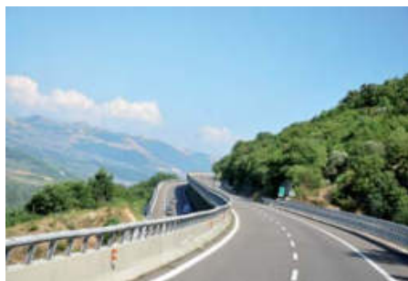
Autostrada poprowadzona w trudnych warunkach terenowych Kalabrii
