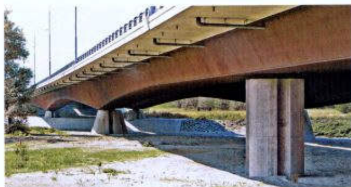
Podwójnie zespolony, skrzynkowy, sprężony most autostradowy przez Odrę w ciągu autostrady D1, Ostrava, Czechy
