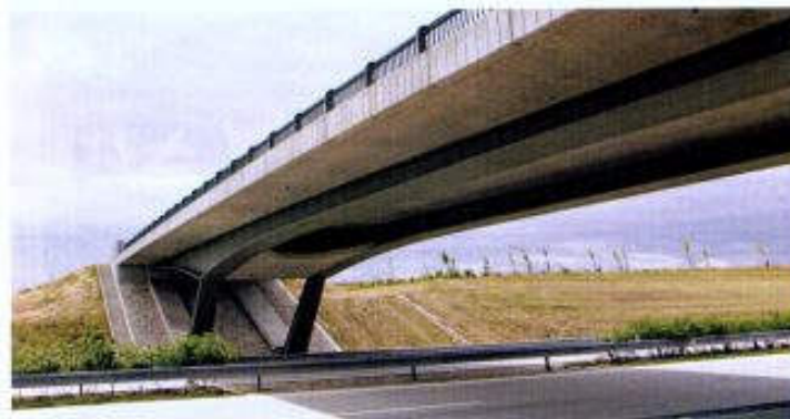
Podwójnie zespolony wiadukt nad autostradą D1, Tišice, Czechy
