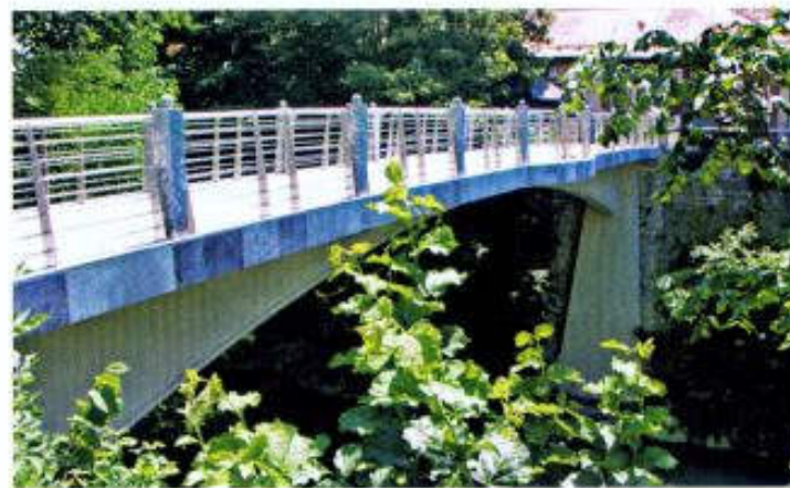
Kładka dla pieszych przez Selšką Sorę, Škofja Loka
