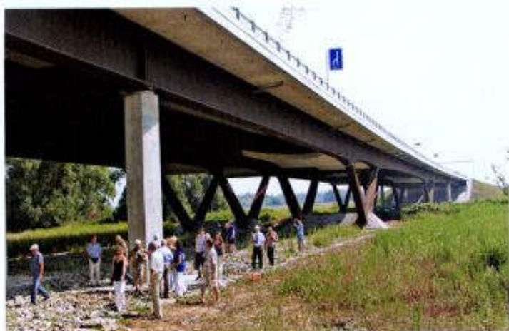
Podwójnie zespolony most autostradowy przez Odrę w ciągu autostrady D1, Stary Bohumin, Czechy
