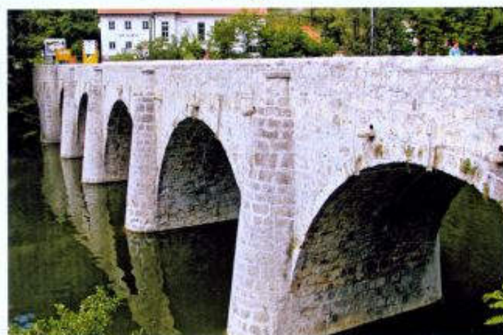
Łukowy most przez Savinję, Zidani Most
