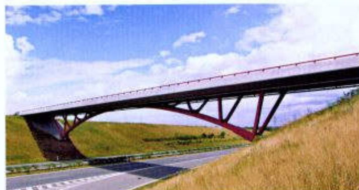
Wiadukt nad drogą ekspresową R52 wykonany według technologii CFST, Bratčice, Czechy
