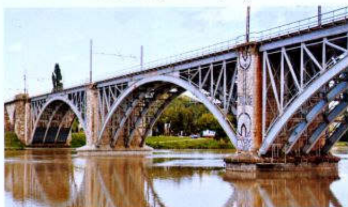
Łukowy most kolejowy przez Dravę, Maribor
