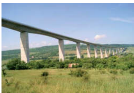
Wiadukt autostradowy Köröshegy (2006 r.)
