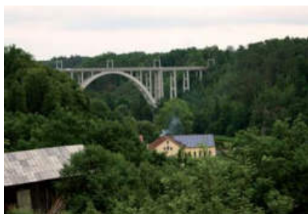
Bechyně – żelbetowy drogowo-kolejowy (1928 r.)
