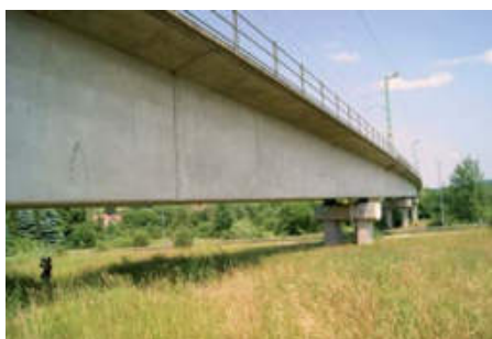
Wiadukt kolejowy w Nagyrákos (2001 r.)
