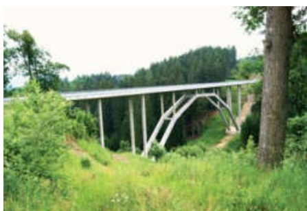
Völkermarkt – z elementów fibrobetonowych (2010 r.)
