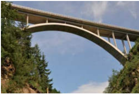
Rys. 4. Lukowy wiadukt autostradowy koło Hütttau, Austria
