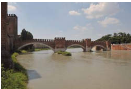
Rys. 10. Ponte Scaligero przez Adygę w Weronie, Włochy
