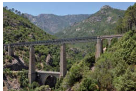
Rys. 21. Most kolejowy projektu Gustava Eiffela w dolinie rzeki Vecchio, Korsyka
