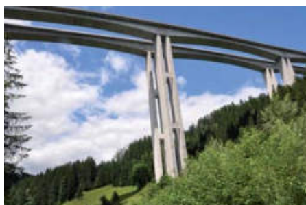
Rys. 29. Ramowy most autostradowy Talübergang w Wolfsberg, Austria
