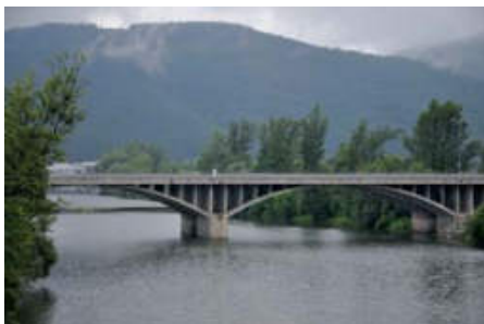
Rys. 34. Żelbetowy most łukowy przez Wag w Považskiej Bystricy, Słowacja
