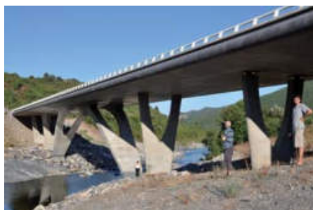
Rys. 23. Żelbetowy most łukowo-plytowy w dolinie rzeki Prunelli, Korsyka
