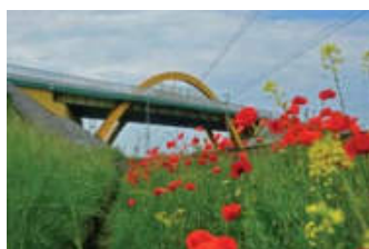
Mariusz Prędota (Warszawa) – „Wiadukt w ciągu DK nr 2 nad E20 koło Kutna”
