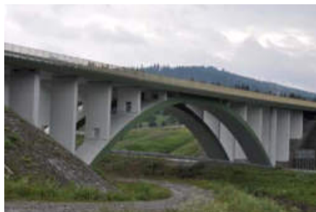
Rys. 35. Żelbetowy łukowy wiadukt w Lalikach Wielkich k/Zwardonia, Polska
