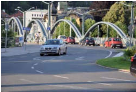
Rys. 7. Most miejski w Salzburgu, podwieszony do wielokrotnych luków stalowych z CSFT
