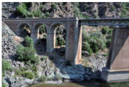
Rys. 16. Most kolejowy przez rzekę Asco, Korsyka
