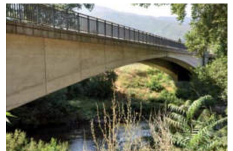
Rys. 15. Belkowy most sprężony przez rzekę Golo w Ponte Nuovo, Korsyka
