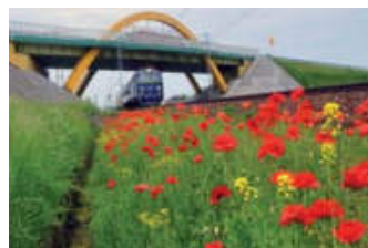
Mariusz Prędotą (Warszawa) – „Wiadukt w ciągu DK nr 2 nad E20 koło Kutna”
