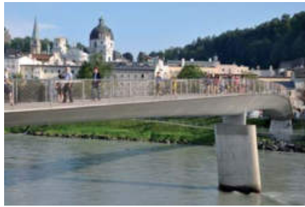
Rys. 5. Sprężona kładka dla pieszych przez Salzach w Salzburgu, Austria
