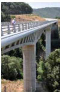
Rys. 13. Betonowy most sprężony w dolinie rzeki Taravo, Korsyka
