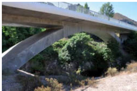
Rys. 19. Żelbetowy most łukowo-belkowy przez rzekę Golo, Korsyka
