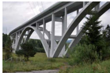
Rys. 36. Sprężony, betonowy most łukowy przez dolinę Kameszniczanek w Milówce, Polska.
