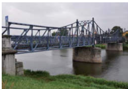
Rys. 32. Zabytkowy most kratownicowy w Kostelanach nad Morawą, Czechy
