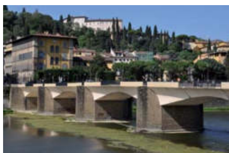
Rys. 26. Żelbetowy most belkowy Ponte Alla Gracie przez Arno we Florencji, Włochy
