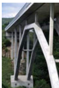
Rys. 28. Sprężony, betonowy most łukowy z prefabrykatów dużej dokładności w Völkermarkt, Austria
