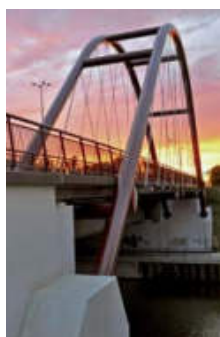
Mariusz Prędotą (Warszawa) – „Kładka pieszo-rowerowa nad Kanałem Żerańskim”
