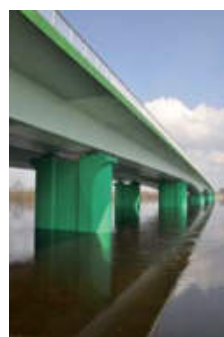
Czesław Prędotą (Warszawa) – „Most przez Bug na S8 w ciągu obwodnicy Wyszkowa”
