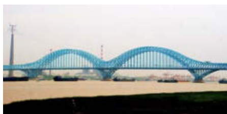
Kolejowy most Dashengguan (2x336 m) dla LDP i metra
