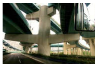
Wspólna podpora estakad drogowych w Szanghaju
