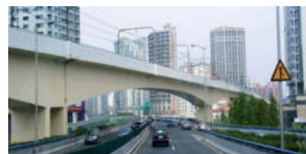
Estakada kolejowa w Szanghaju
