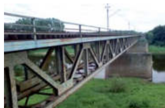
Danuta Witczak (Poznań) – „Most kolejowy przez Wartę w Obornikach”
