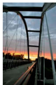
Mariusz Prędotą (Warszawa) – „Kładka pieszo-rowerowa nad Kanałem Żerańskim”
