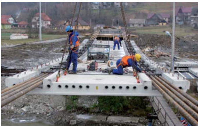
Rys. 5. Montaż wieszaków podtrzymujących element
