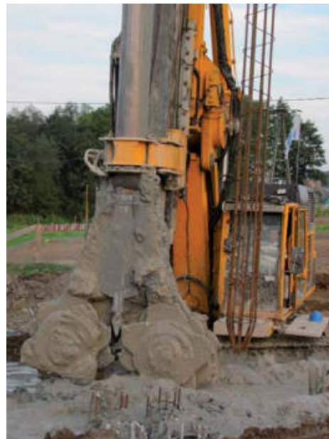
Rys. 3. Wykonywanie pali CSM
