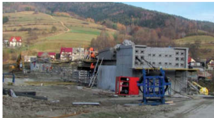
Rys. 2. Korpus przyczółka z łożem ślizgowym
