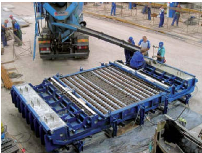
Rys. 4. Betonowanie segmentu w specjalnej formie
