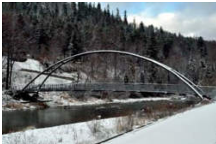
Kładka dla pieszych nad rzeką Sołą w Węgierskiej Górze
