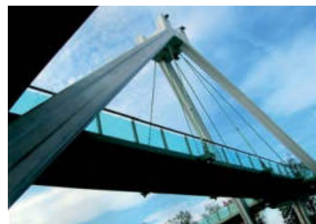
Wyróżnienie – Grzegorz Kopeć „Z innej perspektywy... – podwieszona kładka dla pieszych nad DK1 w Pszczynie”
