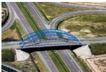
Wiadukty nad A4 węzeł Ropczyce
