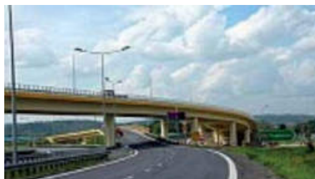
Węzeł Radzikowskiego – Budowa Roku 2014
