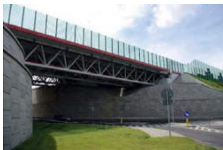
Wiadukt WA-427 w ciągu A1 w Piekarach
