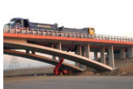
Wiadukty nad A1 w Zabrzu
