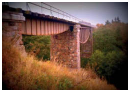
Wyróżnienie – Marcin Graczyk „Most kolejowy na Brdzie w Koronowie”
