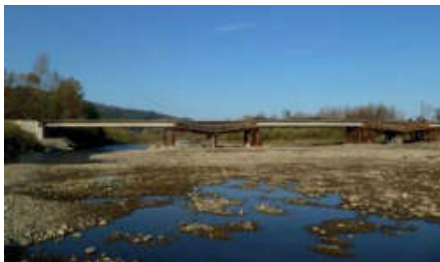
Most „U Drożdźów” w ciągu drogi powiatowej nr 1436 S Cisiec
