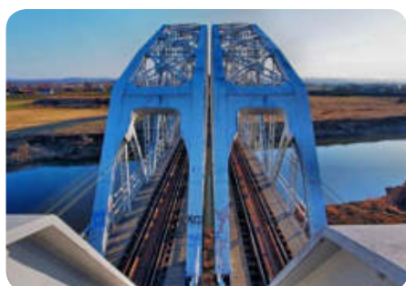
Wojciech Średniawa (Kraków) – Most kolejowy w Niepołomicach na Wisłę
