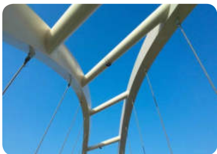
Anna Banaś (Gdańsk) – Wiadukt Nowa Wałowa w Gdańsku
