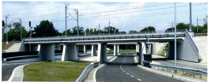
Rys. 4. Widok obiektów przed oddaniem do użytkowania
