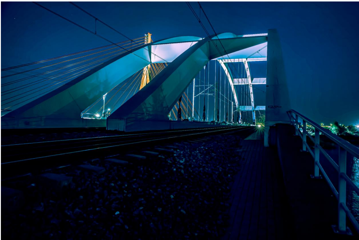
Most Kolejowy, Gdańsk Przeróbka, Most Kolejowy - Port Północny, Mariusz Paszek fot 95
