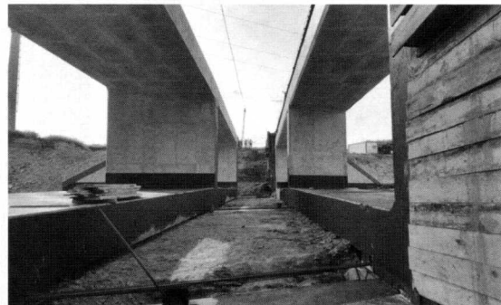
Rys. 3. Widok przemieszczania żelbetowych „połówek” wiaduktu WK-6
