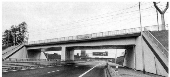
Rys. 4. Widok ogólny wiaduktu WK-6 przed oddaniem do użytkowania
