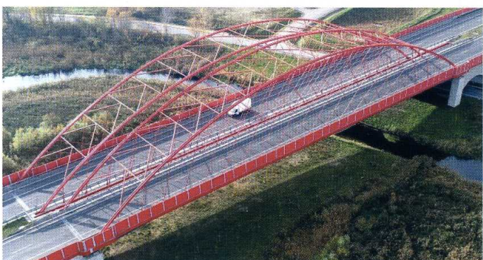
Rys. 16. Widok ogólny obiektu po oddaniu do użytkowania (fot. Budimex S.A., 10/2021 r.)
