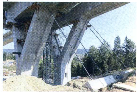
Rys. 3. Budowa obiektu – wybrane przykłady (fot. A. Kasprzak): a) rusztowanie i deskowanie przęseł dojazdowych, b) budowa podpór „Y”, c) równoważenie budowy wspornikowej odciągami kotwionymi w gruncie
