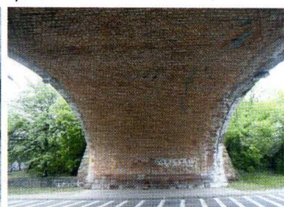
Rys. 7. Przykłady uszkodzeń wiaduku, stan z 2018 r.: a) uszkodzone i brakujące kamienne balustrady [10], b) szczegóły uszkodzeń kamiennej okładziny (fot. K. Dobuszyński ), c) ceglana okładzina łuku (fot. K. Dobuszyński )
