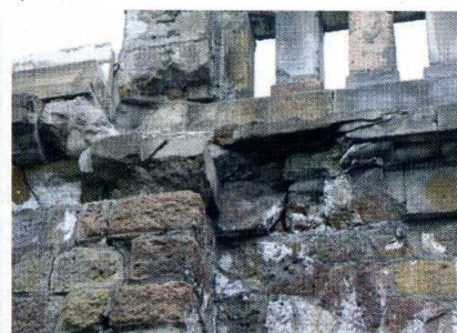
Rys. 7. Przykłady uszkodzeń wiaduku, stan z 2018 r.: a) uszkodzone i brakujące kamienne balustrady [10], b) szczegóły uszkodzeń kamiennej okładziny (fot. K. Dobuszyński ), c) ceglana okładzina łuku (fot. K. Dobuszyński )
