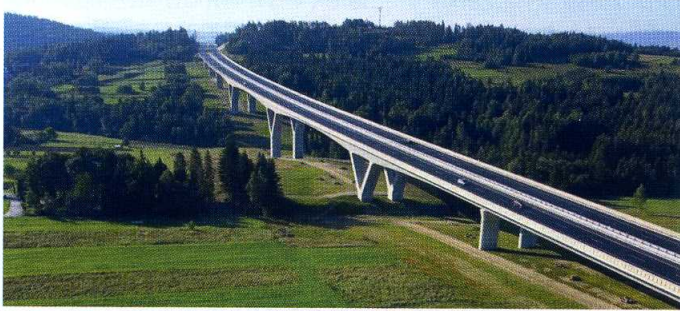
Rys. 4. Widok ogólny wiaduktów w Skomialnej Białej (fot. GDDKiA)
