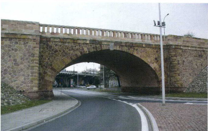
Rys. 10. Ogólny widok wiaduktu po remoncie, stan z 21.11.2021 (fot. W. Trochymiak)
