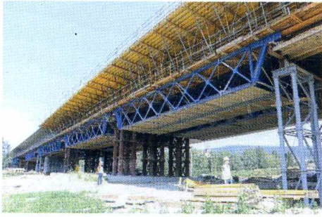
Rys. 3. Budowa obiektu – wybrane przykłady (fot. A. Kasprzak): a) rusztowanie i deskowanie przęseł dojazdowych, b) budowa podpór „Y”, c) równoważenie budowy wspornikowej odciągami kotwionymi w gruncie
