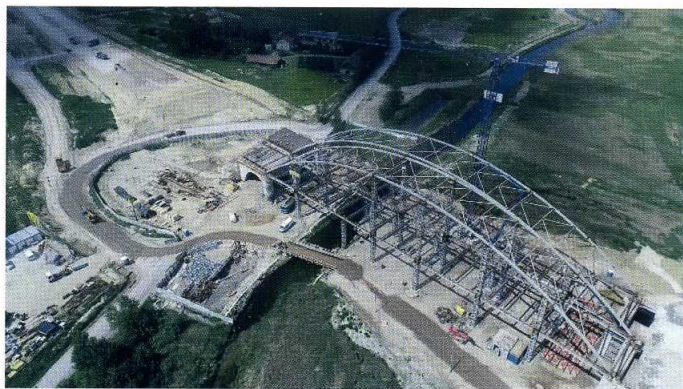
Rys. 13. Ilustracja montażu konstrukcji stalowej [9]
