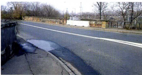
Rys. 7. Przykłady uszkodzeń wiaduku, stan z 2018 r.: a) uszkodzone i brakujące kamienne balustrady [10], b) szczegóły uszkodzeń kamiennej okładziny (fot. K. Dobuszyński ), c) ceglana okładzina łuku (fot. K. Dobuszyński )
