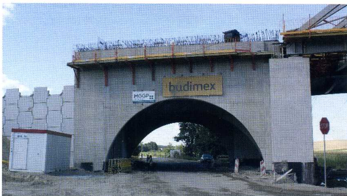
Rys. 14. Widok budowy przyczółka „przejazdowego” [9]
