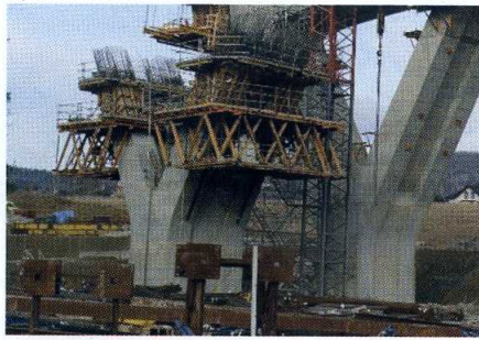
Rys. 3. Budowa obiektu – wybrane przykłady (fot. A. Kasprzak): a) rusztowanie i deskowanie przęseł dojazdowych, b) budowa podpór „Y”, c) równoważenie budowy wspornikowej odciągami kotwionymi w gruncie
