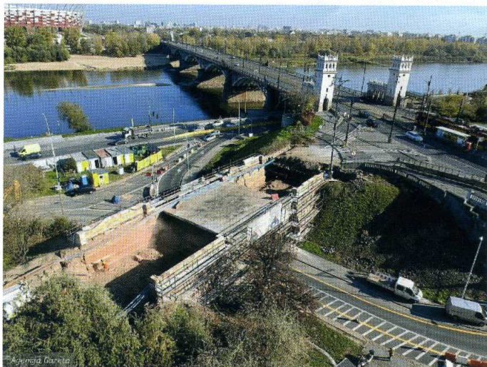
Rys. 9. Remont – widok z góry (fot. GW-Agencja-Gazeta-z25507920IH, Most-Poniatowskiego-Remont-wiaduktu)
