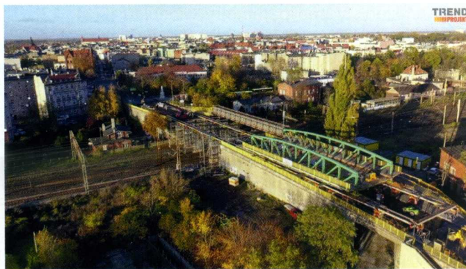
Rys. 10. Widok z góry placu budowy i przesuniętej konstrukcji nośnej wiaduktu (fot. Trend Projekt) [4]
