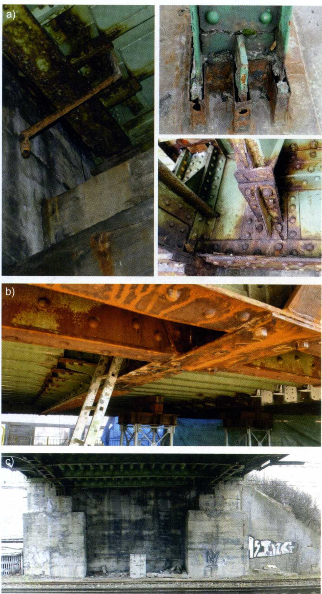
Rys. 8. Przykłady uszkodzeń wiaduku sprzed rewitalizacji [4]: a) szczegóły skorodowanych elementów konstrukcji stalowej, b) widok od spodu konstrukcji nośnej podczas prac remontowych, c) widok przyczółka przed rozpoczęciem prac remontowych
