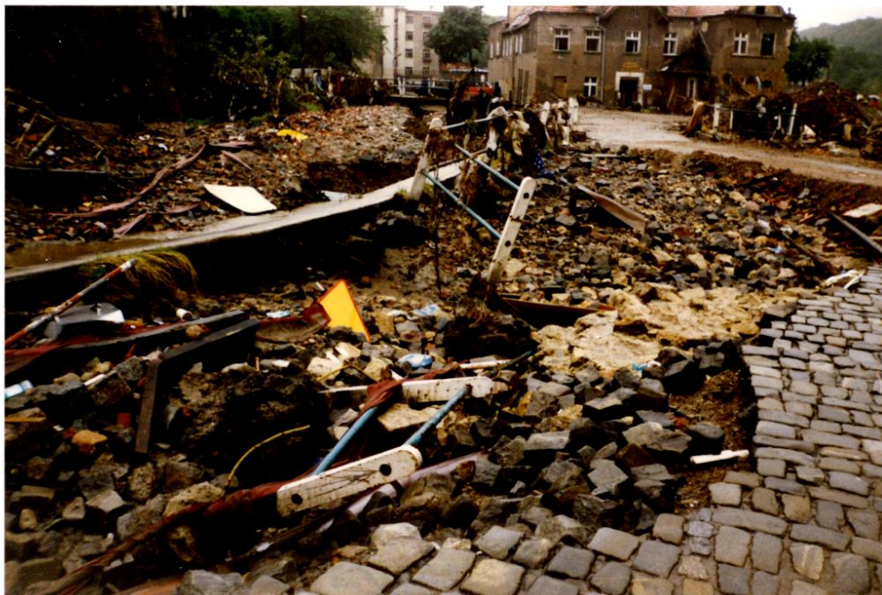
Fot. 17. Wyrwy w strefie nadbrzeżnej ulic w Kłodzku, 18-19.07.1997 r.
