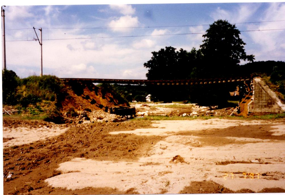
Fot. 7. Linia kolejowa Wrocław Międzylesie - widok rozmytego mostu kolejowego nad suchodołem na trasie Kłodzko - Międzygórze, 27.07.1997 r.
