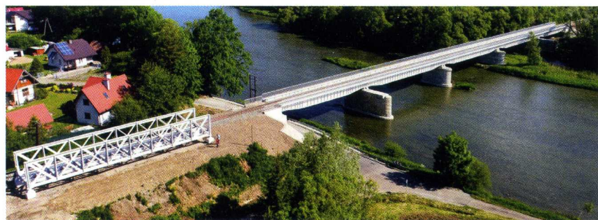
Rys. 6. Widok mostu po modernizacji z fragmentem starego przęsła jako pomnika techniki (fot. Maciej Kuczma) [6]
