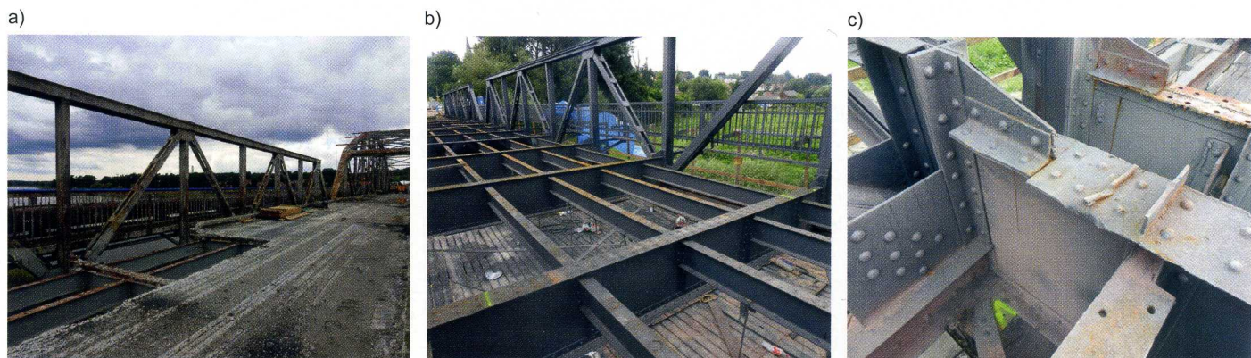
Rys. 11. Przykłady prac remontowych [7, 11]: a) demontaż płyty pomostu i odsłanianie elementów konstrukcji stalowej, b) stalowe elementy konstrukcji pomostu po naprawie i oczyszczeniu, c) szczegóły węzła konstrukcyjnego z nowymi fragmentami konstrukcji
