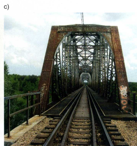
Rys. 13. Most kolejowy w ciągu lk nr 8, na odcinku Warka – Radom, nad Pilicą (fot. 11/06/2013) [12]: a) widok ogólny, b) widok podpory pośredniej, c) widok podsytkowej nawierzchni z roboczymi pomostami
