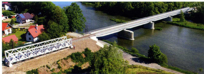
Rys. 6. Widok mostu po modernizacji z fragmentem starego przęsła jako pomnikiem techniki (fot. Maciej Kuczma) [6]
