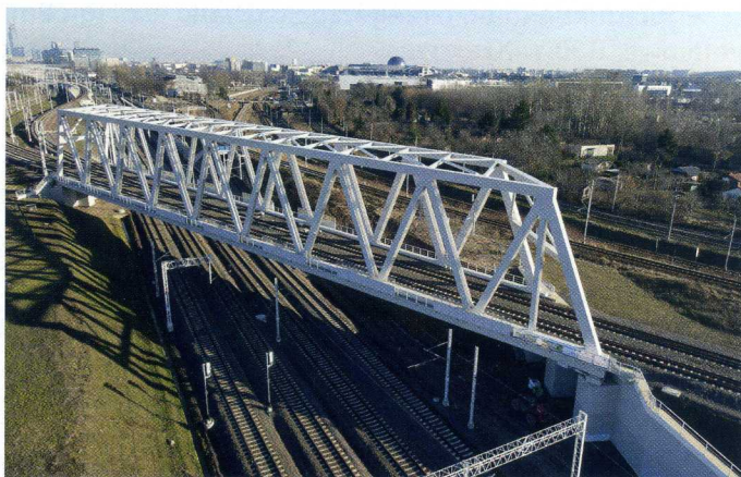
Rys. 6. Widok ogólny wiaduktu M.01 po oddaniu do użytkowania [1]
