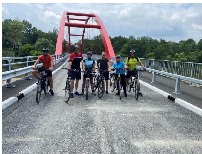
Fot. 1. Uczestnicy wycieczki rowerowej na tle nowego mostu stalowego na rzece San w miejscowości Bieliny (fot. Oddział Rzeszowsko-Lubelski ZMRP)
