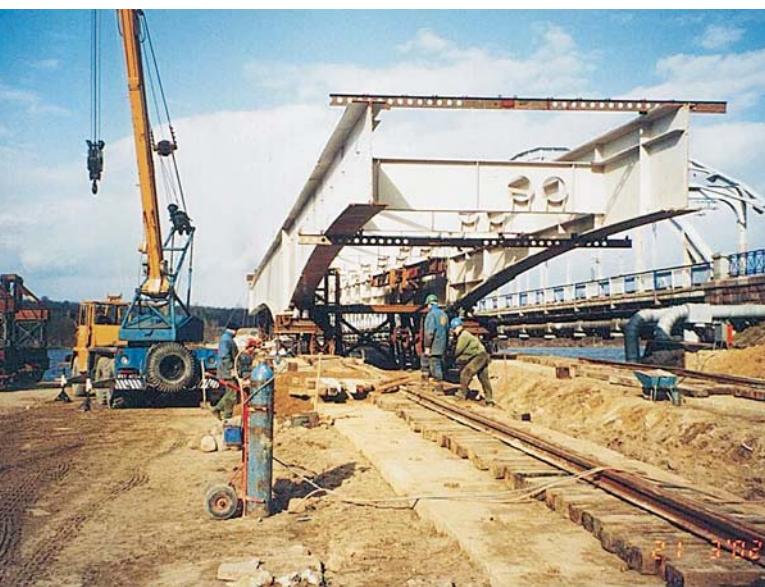
Montaż konstrukcji stalowej na brzegu
