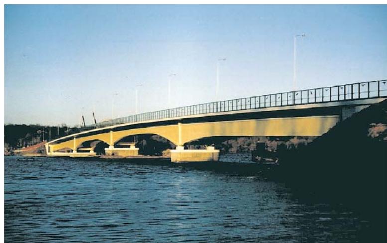
Widok zbudowanego mostu
