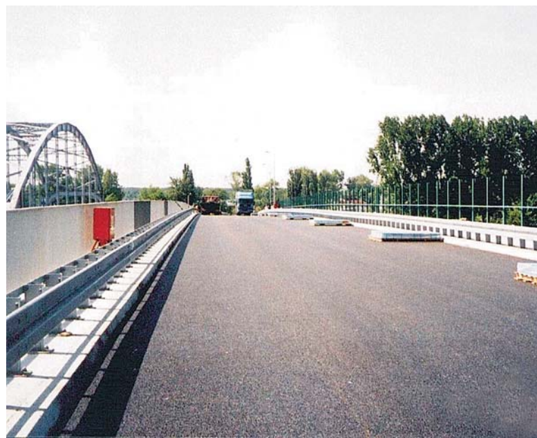
Roboty wykończeniowe na moście; elementy ekranów dźwiękochłonnych przygotowane do montażu
