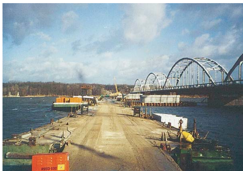
Dojazd do podpór pośrednich mostem pływającym
