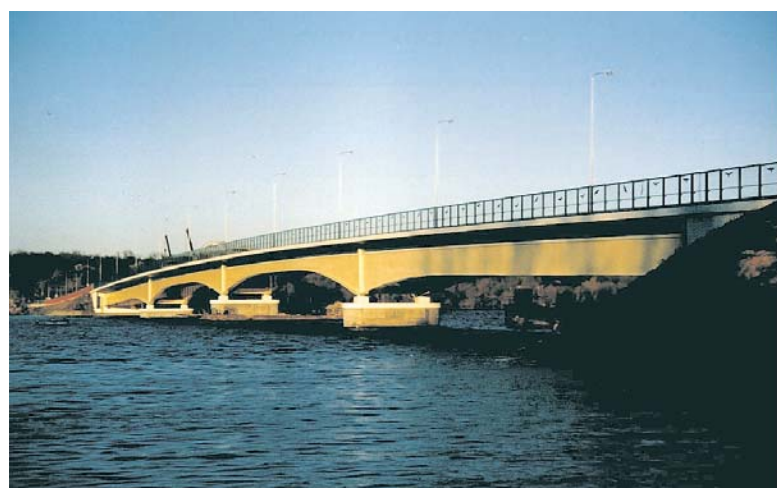
Widok zbudowanego mostu
