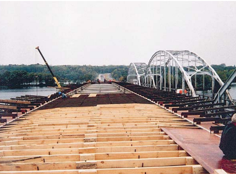
Konstrukcja wsporcza dla wykonania deskowania płyty pomostu
