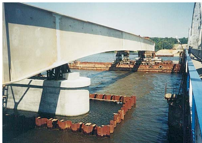
Nasuwanie konstrukcji za pomocą podpory pływającej
