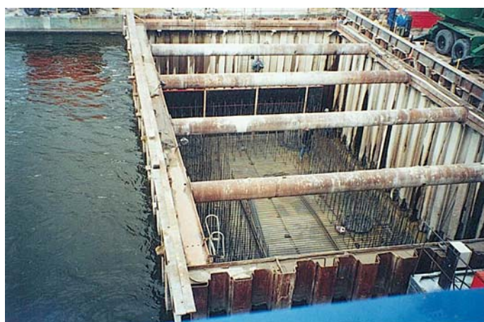
Zbrojenie fundamentu nr 3
