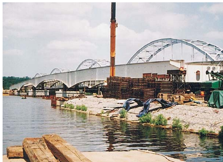
Konstrukcja nasunięta na podpory
