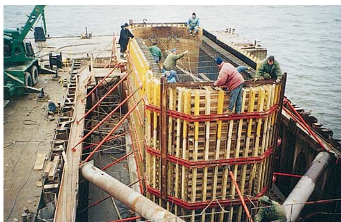
Deskowanie filara podpory nr 2
