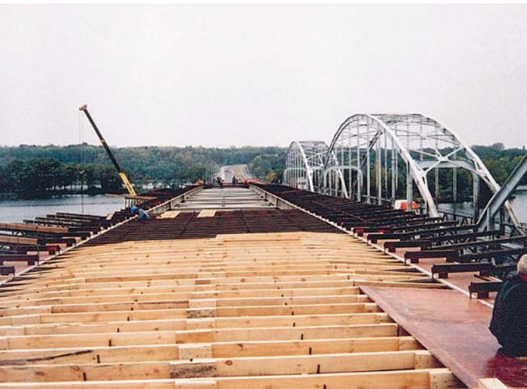
Konstrukcja wsporcza dla wykonania deskowania płyty pomostu
